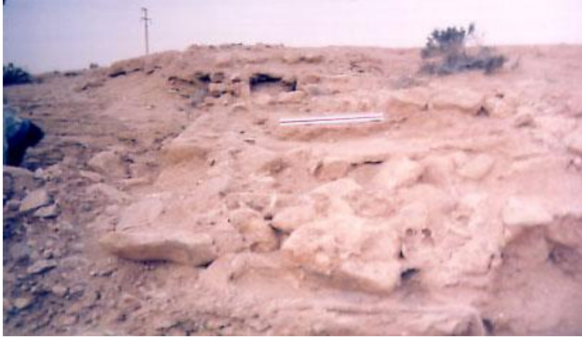
الصورة 03: القناة المبنية شمال موقع تهودة الاثري. عن: تريعة، السعيد، 2008م.
