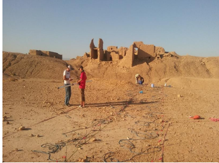
الصورة 03: ربط الأقطاب الحديدية بالأسلاك الكهربائية، عن:
