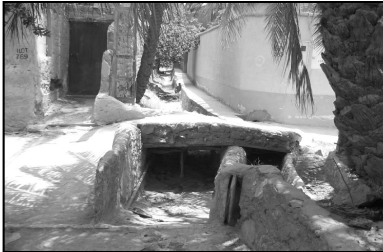
Figure 5. Ghardaia-Nord, ruelles de la palmeraie servant de réseau de distribution de l'eau des crues. Les fentes de droite représentent un exemple de parts d'eau
