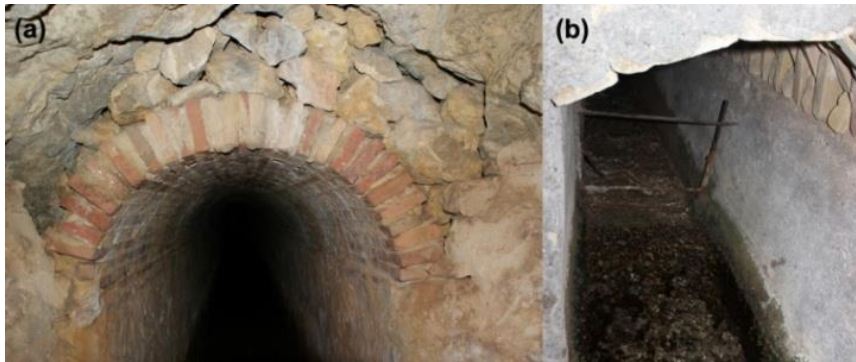
Figure 5. Etalement en pierres et voûtes en briques cuites locales des tunnels de galeries d'eau : (a) La galerie d'eau Font Del Port à Albaida, province de Valence, Espagne, juillet 2014 ; (b) Le qanat de Ghassem Abad au sud de Yazd, Iran, novembre 2014.
