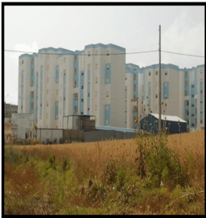
Photo 1: La prolifération des logements AADL sur les bordures des terres agricoles à Barbessa
