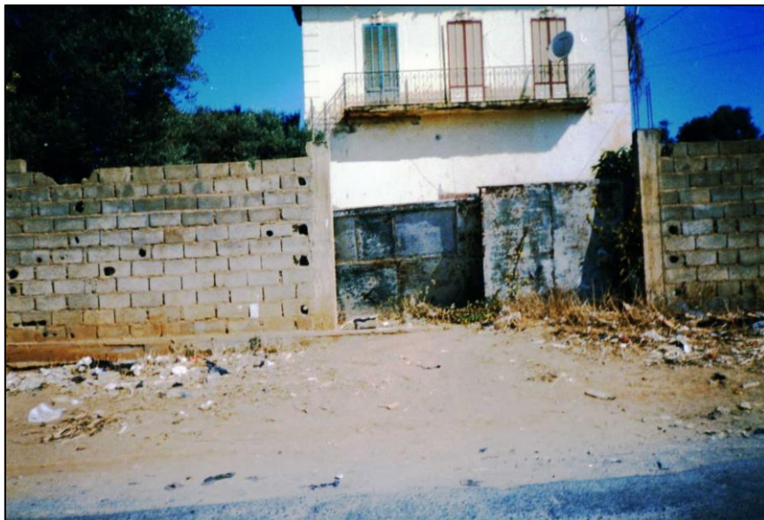
Photo 2 : Les extension illicites sur l'habitat individuel colonial formant alignement sur la RN 67
