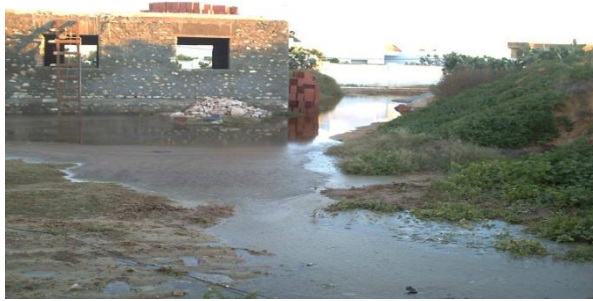
Figure 7. Photo indiquant l'Inaptitude d'infiltration et stagnation de l'eau pluviale pendant des jours à Sakiet-Eddmaier à cause de la remontée des eaux de la nappe phréatique
