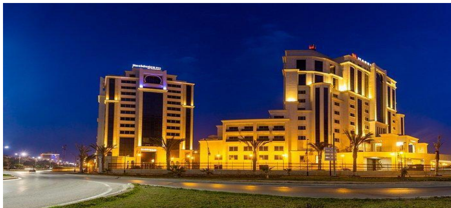
Figure4: Algiers Marriott Hotel Bab Ezzouar
