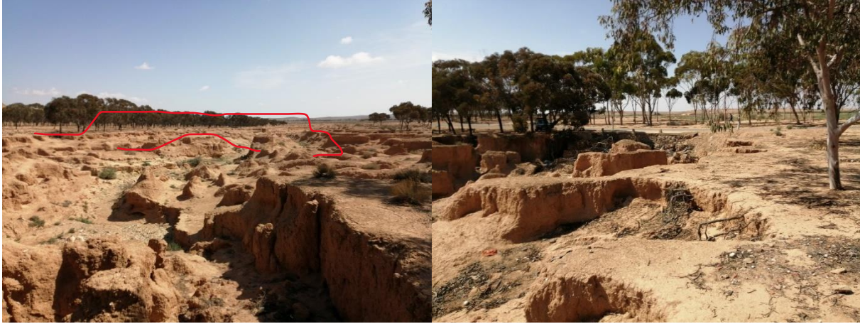
الصورة رقم 11: طريق مهددة بسبب التعرية التراجعية، الطريق الرابطة بين حامة قطيضر والطريق الوطنية 6
