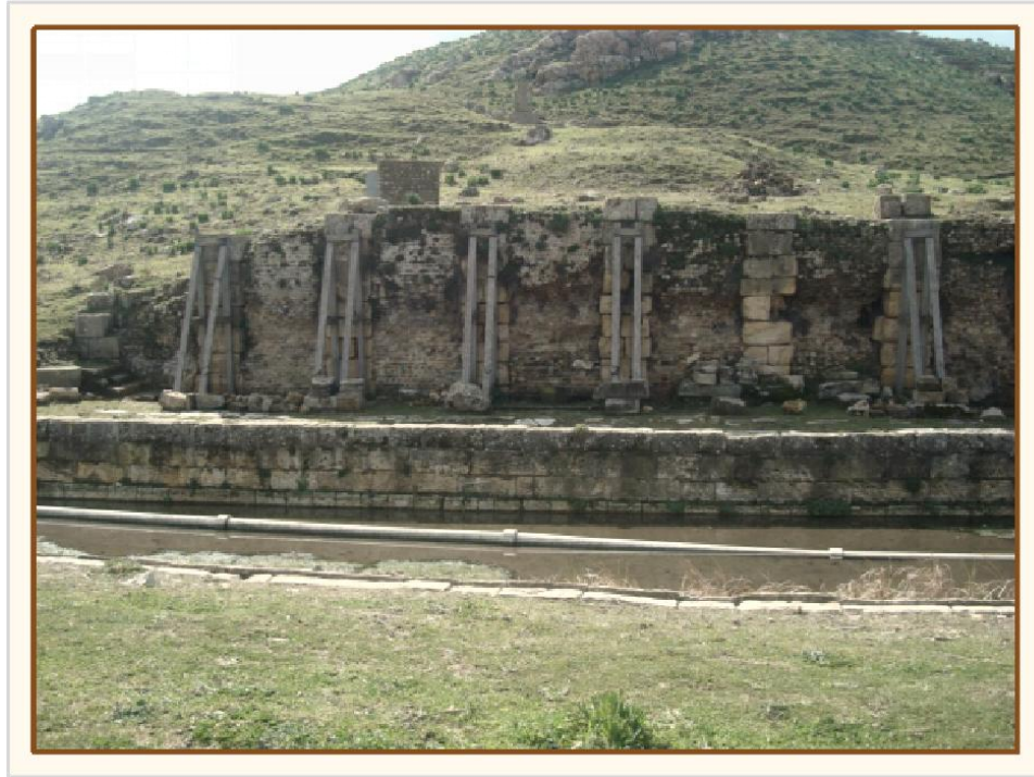
Figure 13: Mur de soutènement du plateau
