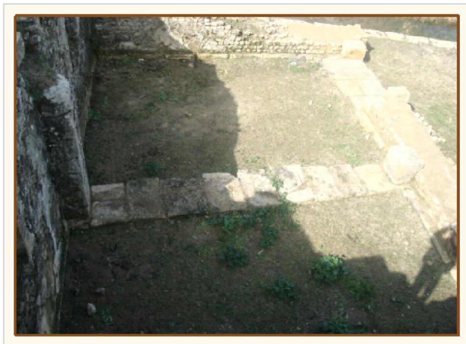
Figure 6: Mur de séparation entre les deux cellae
