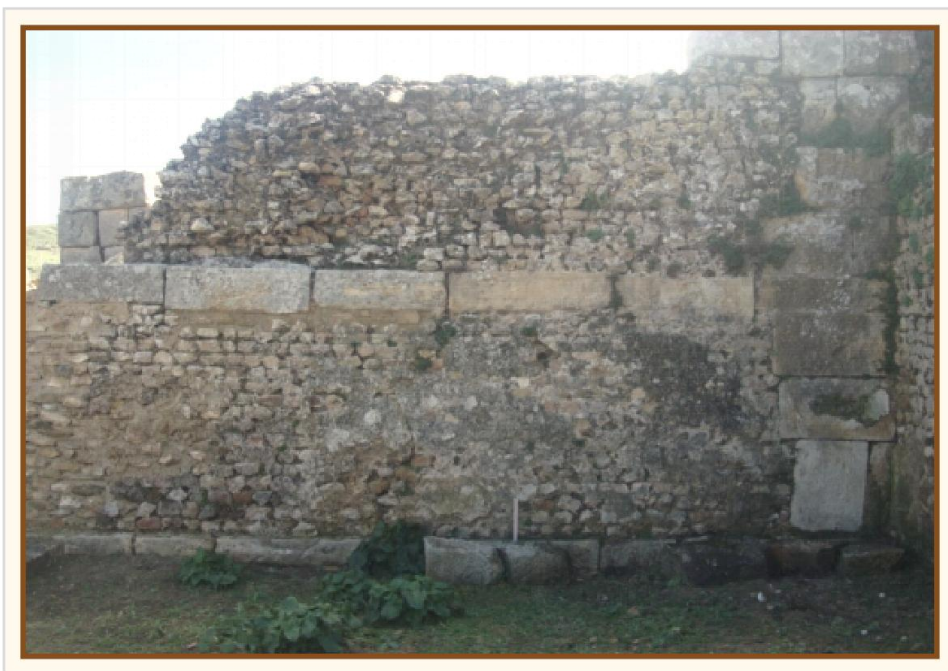
Figure 10: Chaînage horizontal de la cella orientale
