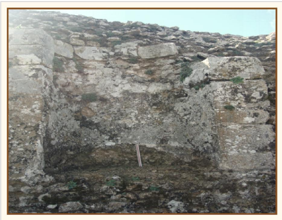
Figure 8: Niche de la cella occidentale
