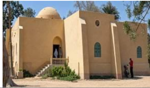
(أ) الواجهة البحرية
