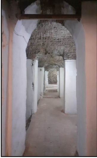
الصورة 4: الرواق المستحدث داخل
