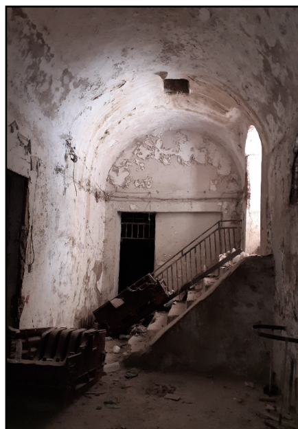
الصورة 5: مدخل الخزان
