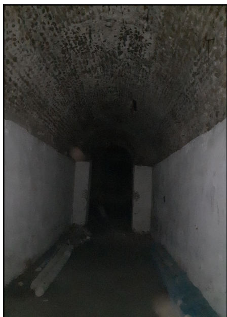
الصورة 6: وضعية التليبس في إحدى غرف الخزان
