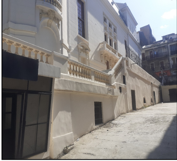
الصورة 3: المدخل الجاني للخران المائي
