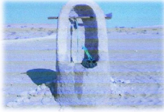
شكل رقم (8): تقنية الجر بالبكرات
