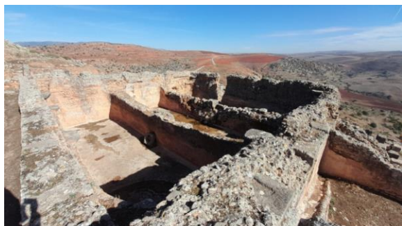
Picture N° 08 of water réservoir- Tiddis site
