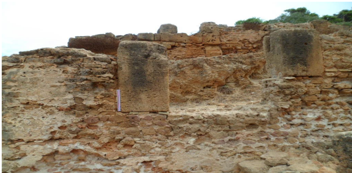
photo n°12 : Le mur est construit à l'aide d'une technologie africaine (la mienne)
