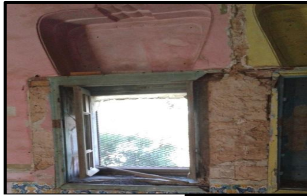
صورة 12: عقد مقبض القفة لنافذة بقصر الداوي
