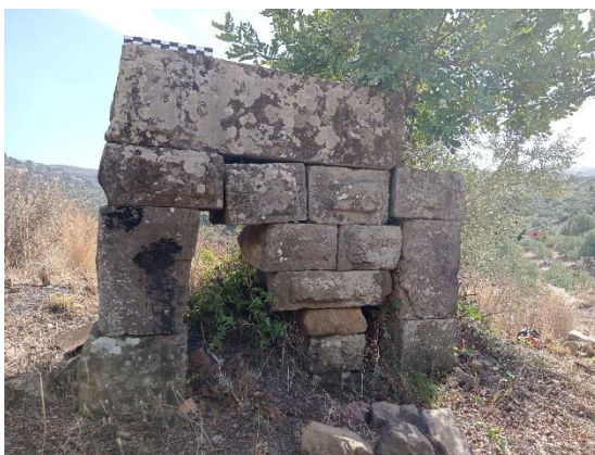
Figure n°17: Vue extérieure d'une façade. (Khoulf. K)
