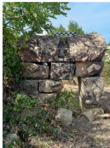
Figure n°18: Vue intérieur de la même façade. (Khoulf. K)
