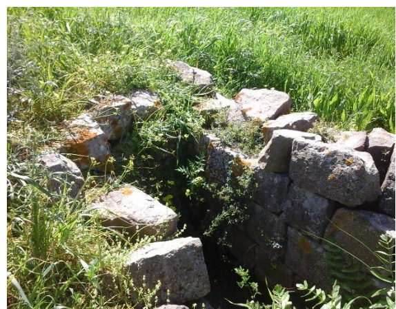
Figure n° 30 : Source d'eau (Khoulf. K)
