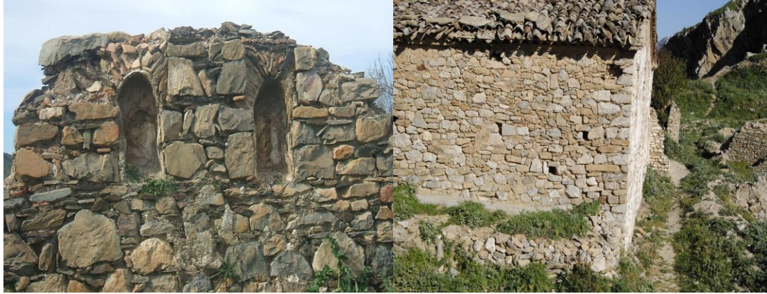
الصورة 1: استعمال الحجارة في بناء الأسوار.
