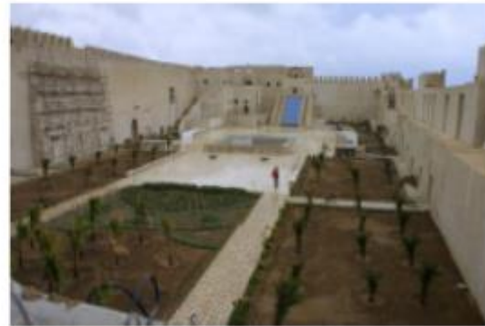
4. صورة بالورامية لفضاء القصبة اثر انتهاء الاشغال
