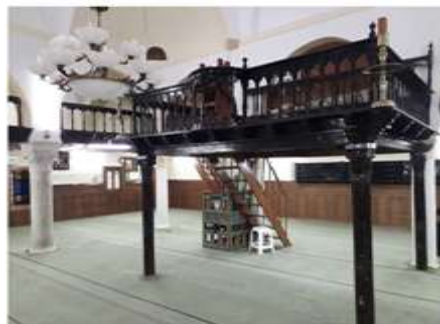
الصورة 02 : سلم دكة المبلع بجوامع صفر بالجزائر
