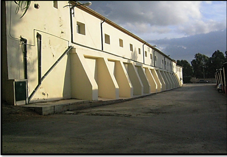
صورة رقم 06: عمليات تدعيم وترميم الواجهة الغربية لبرج القنيطرة
