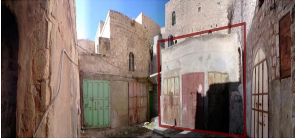
صورة (1) تبين المحال التجارية التي قد تم اضافتها في مبنى خان الوكالة
