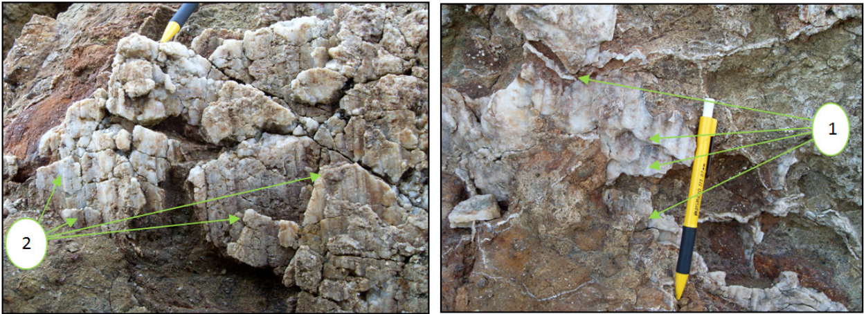
Fig. 14 - Vue de miroir de faille (N060°E)
