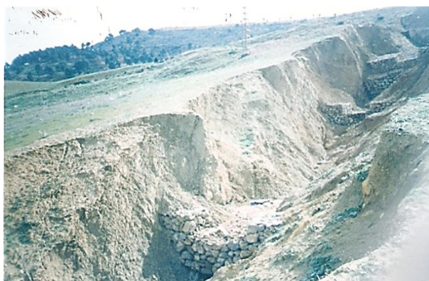
Figure 6. Correction torrentielle ; seuils en gabion Haouch Zegaa (Ouzera) – le 27/03/2007
