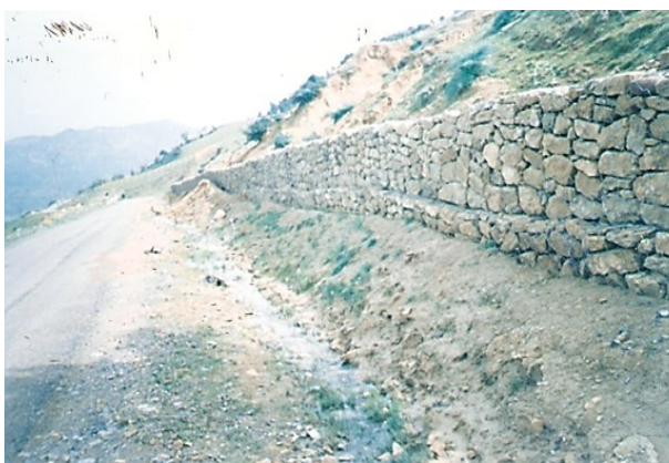
Figure 7. Correction torrentielle : mur de soutènement Haouch Zegaa (Ouzera). Fossé naturel d'écoulement qui longe la route - 27/03/2007
