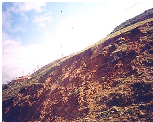
Figure 3. Glissement de terrain.
