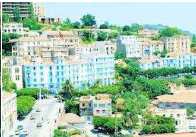
Figure N° 07 : Héritage de l'architecture coloniale (ancienne ville)
