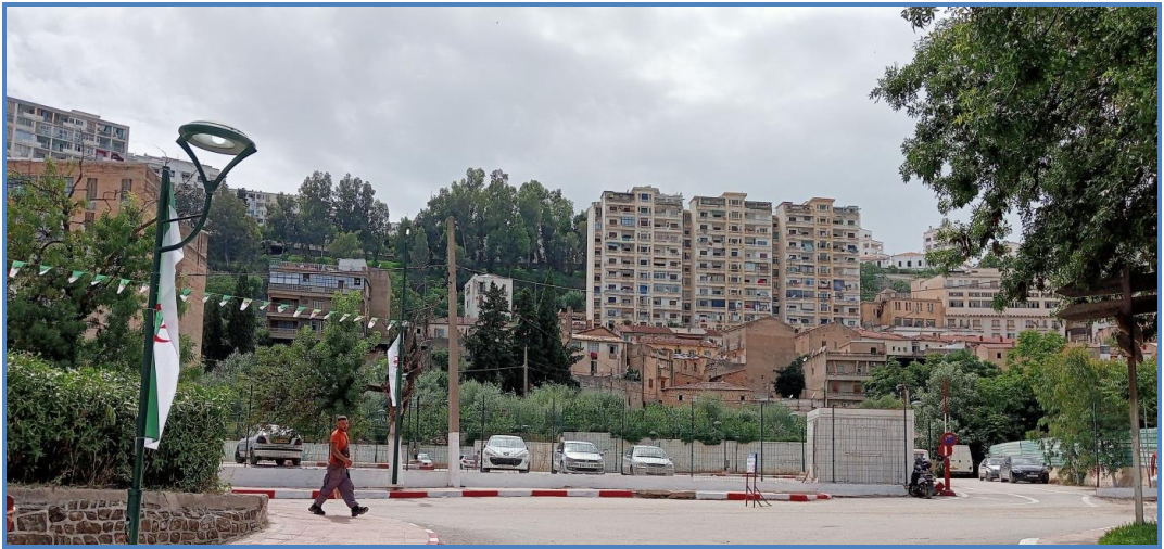
Figure N° 07 : Etat des lieux de l'Avenue Rahmani Achour
