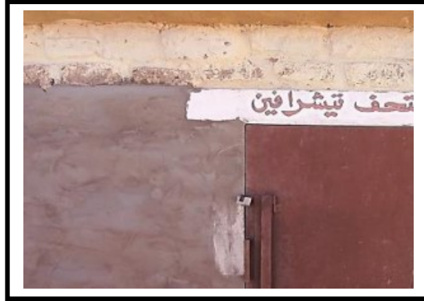
الصورة 12: استعمال مواد حديثة فوق مباني أثرية ( تصوير الباحثة ).
