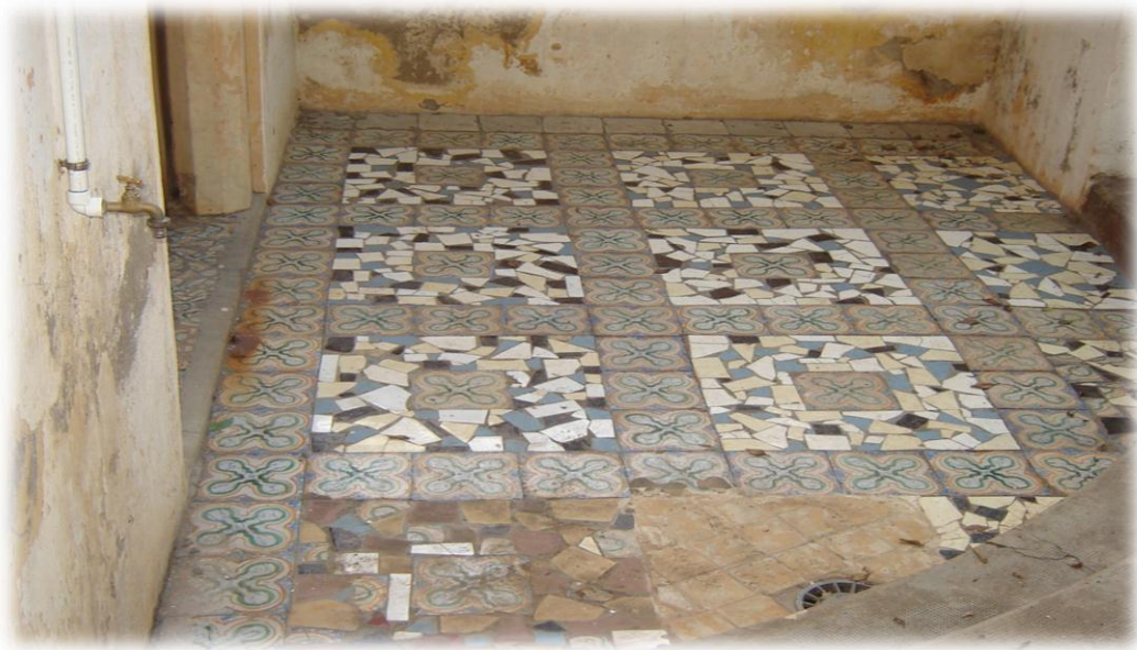
الصورة رقم 07 آثار الأملاح المتبلورة على الأسطح
