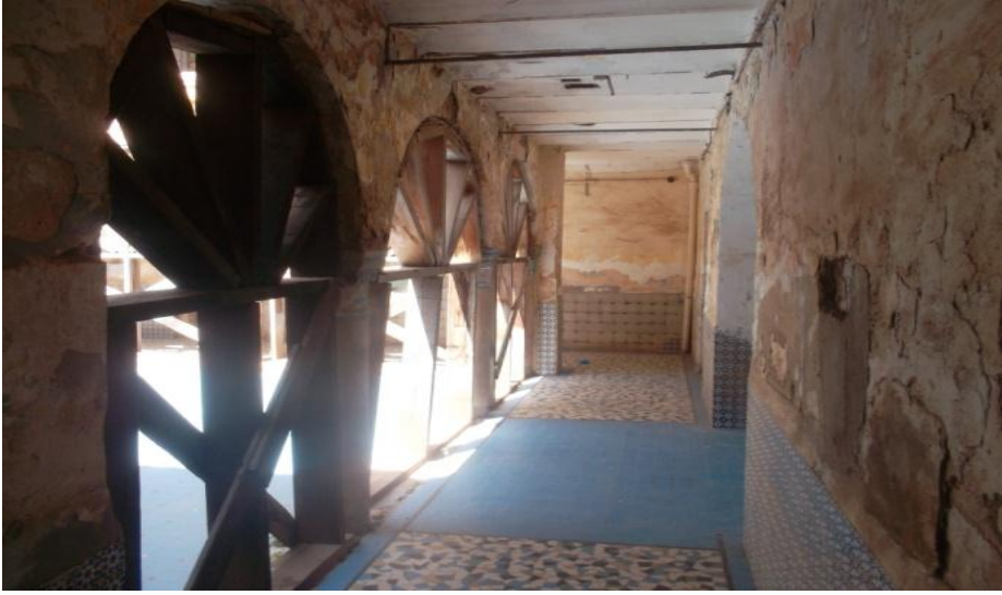
الصورة رقم 05 تفتت في الأسطح الداخلية
