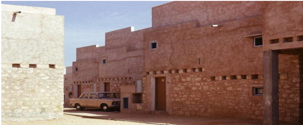
Fig. 10. Murs en pierre et ouvertures aux dimensions réduites comme dispositifs pour le contrôle de l'ensoleillement et de l'éclairage naturel dans les habitations du quartier de Sidi Abbaz conçu par André Ravéreau
