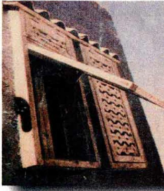
Fig.8 . Le moucharabieh: un dispositif de contrôle solaire et de réconfort (de l'intimité) accompagnant la conception des fenêtres dans le quartier d'habitat semi-collectif à Ouled Djellal-Biskra
