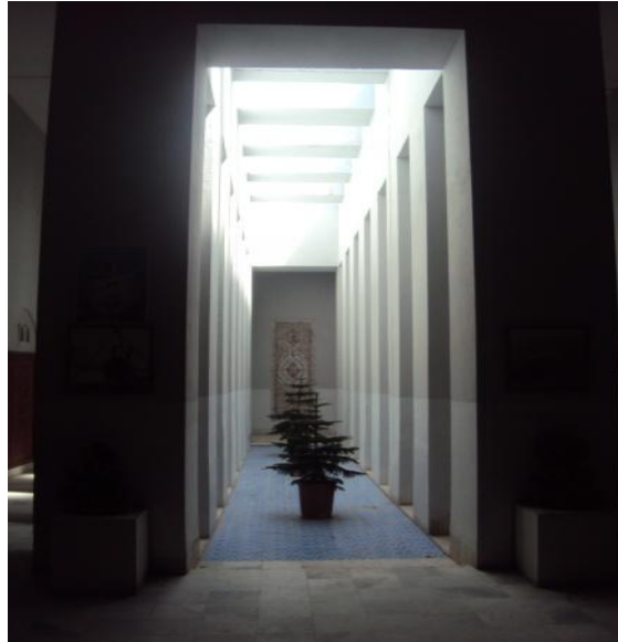
Fig. 18. Dispositif d'éclairage naturel zénithal dans un patio de la préfecture d'Ouargla
