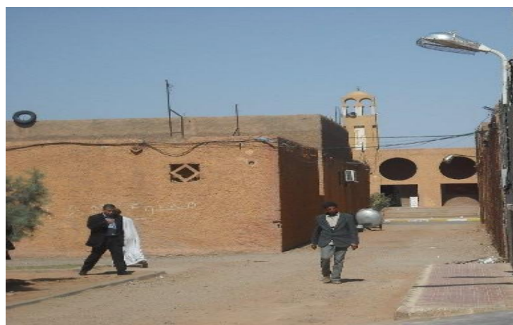
Fig.3. Les fenêtres aux dimensions réduites dans les maisons du village socialiste agricole de Abadla
