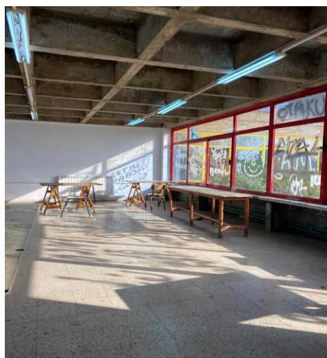
Fig.13. Tâches solaires et lumière naturelle contrôlées au moyen de la végétation extérieure et texture rugueuse du béton brut dans un atelier de l'école polytechnique d'architecture et d'urbanisme
