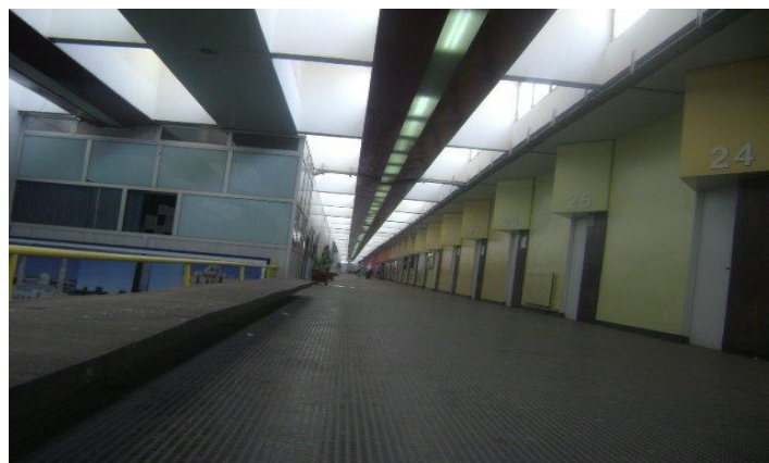
Fig. 1. Vue des dispositifs architecturaux assurant l'éclairage naturel zénithal des couloirs du bloc des Lettres à l'université de Constantine conçue par l'architecte Oscar Niemeyer
