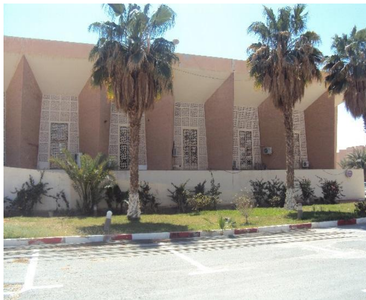
Fig. 16. Vue sur les grandes ouvertures des bureaux de la préfecture d'Ouargla protégées par des moucharabiehs en guise de dispositifs de protection solaire
