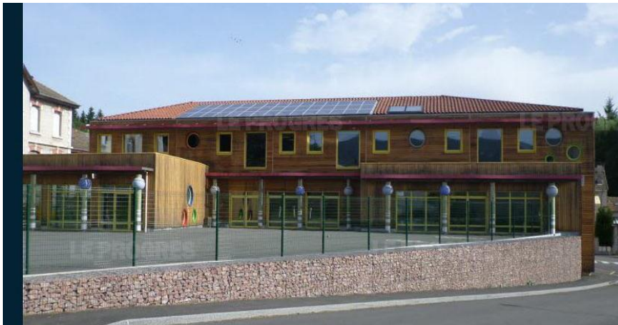
Fig. n°13 : Une école primaire écologique, en France, construite en 2008 : panneaux solaires sur le toit et matériaux de construction en bois.
