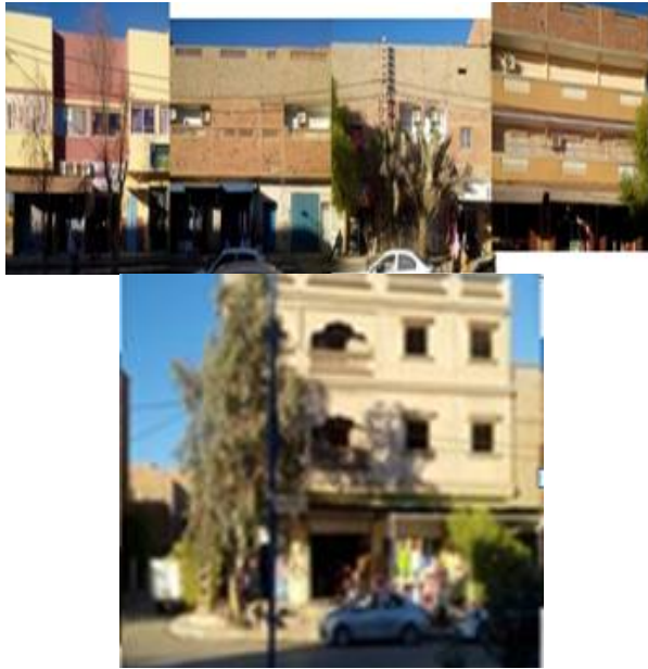
Photo 13: Nouvelles façades de la ville de Béchar.
