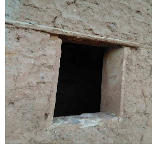
Photo 6 : linteau en bois
