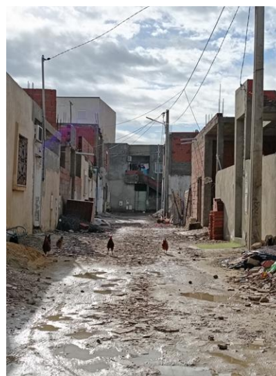
Fig.4. Rue interne non viabilisée après la pluie
