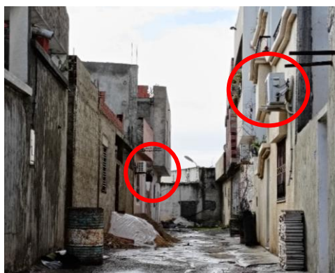
Fig.7. Climatiseurs sur logements inachevés
