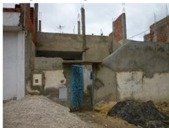
Fig.14 : Stockage des matériaux
