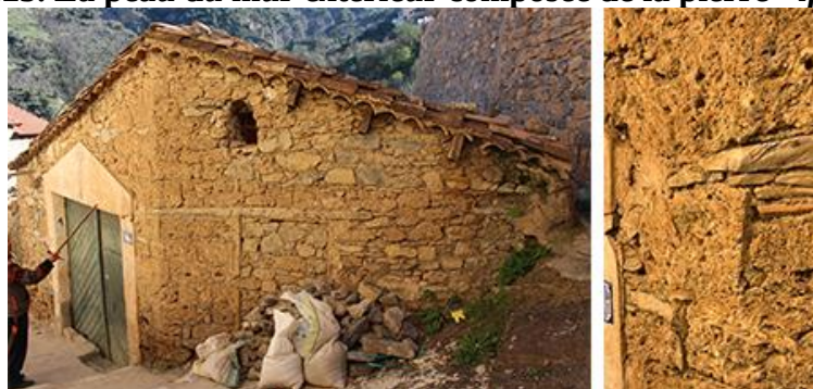
Fig.25. La peau du mur extérieur composée de la pierre "ifssir"
