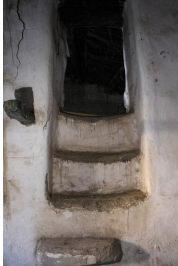
Fig.26. Accès à la chambre "Taëriçt" en mezzanine par quelques marches
