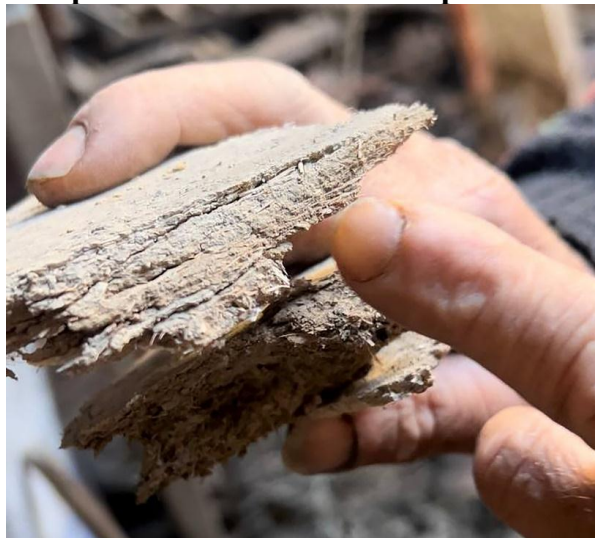
Fig.24. La peau du mur intérieur composée de "oumlil"
