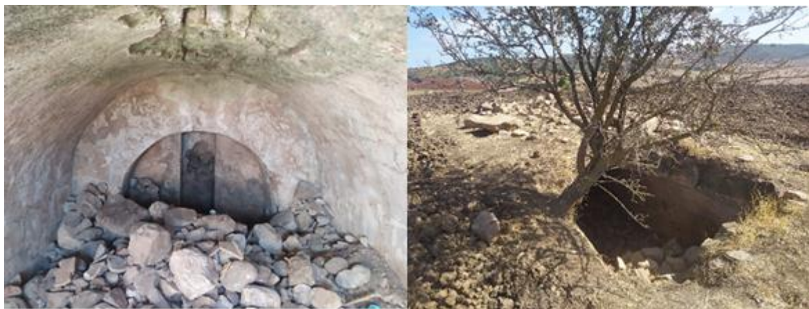
Fig. 3 : vestiges d'une citerne (face interne et externe)( photo hakim hamida)
