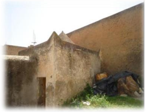
صورة رقم 7: ضريح سيدي بوقطاية
