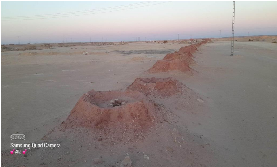
الملحق 2: (صورة فتوغرافية تبين الشكل الخارجي للفقارة).
