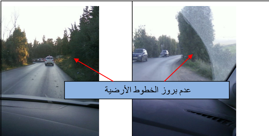
الشكل رقم (04): يوضح عدم بروز الإشارات المرورية الأرضية
