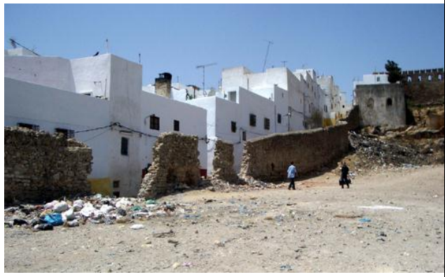
الصورتان رقم 02 و 03: انهيار أجزاء من سور المدينة الممتدة من باب المقابر إلى قصبة جبل درسة وإعادة بنائها من جديد
