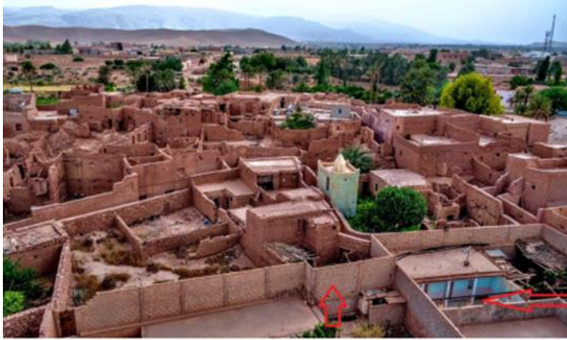
الصورة 03: منظر جانبي لقصر تيوت يبرز عمليات التحديث.
