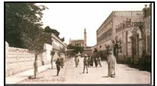
Photo2 : L'avenue Cassaigne (la porte d'Alger).
