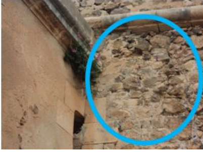
اللوحة رقم 3 توضح تآكل وثغرات على مستوى الأسطح الخارجية بقلعة سانتا كروز
