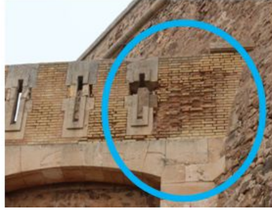
اللوحة رقم 3 توضح تآكل وثغرات على مستوى الأسطح الخارجية بقلعة سانتا كروز
