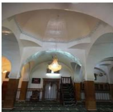
الصورة 04: منظر داخلي لبيت صلاة مسجد مدرسة مازونة
