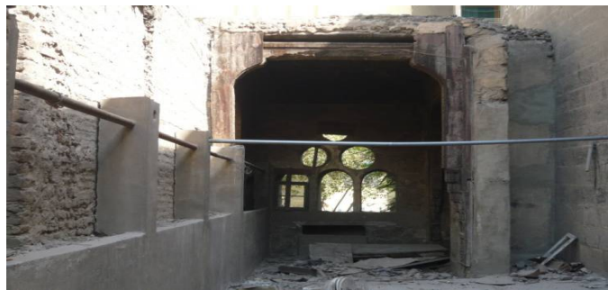
صورة (3): توضح إلقاء القمامة على سطح المدرسة
