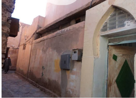
الصورة رقم 09-10-11: توضح سوء توصيل الوسائل الحديثة واستعمال الاسمنت
