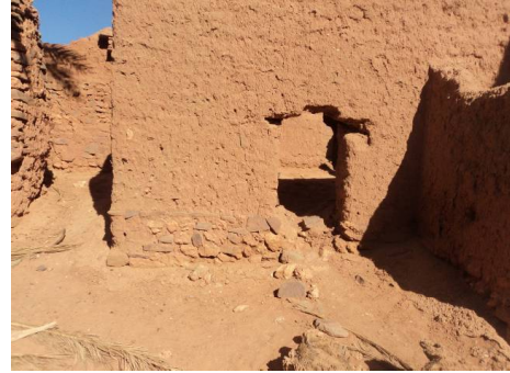
الصورتان رقم 12 و 13: توضحان انهيار أجزاء كبيرة من القصر بسبب هشاشة مواد البناء وتلاشي وقدم الملاط الرابط بين المواد
