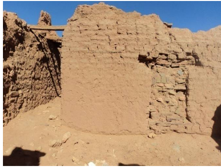
الصورتان رقم 12 و 13: توضحان انهيار أجزاء كبيرة من القصر بسبب هشاشة مواد البناء وتلاشي وقدم الملاط الرابط بين المواد
