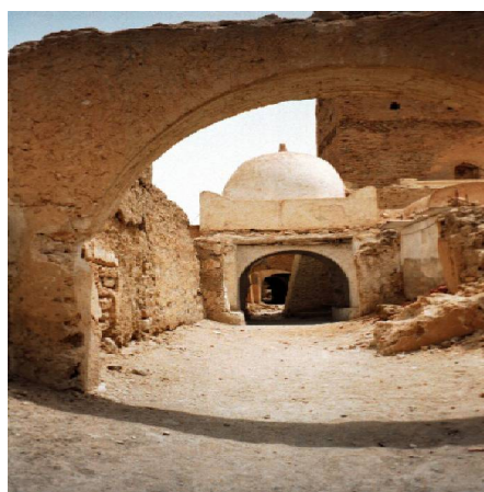
صورة رقم (07): قبيلة المدخل الرئيسي لمسجد سيدي عبد الله المغراوي قصر تماسين
