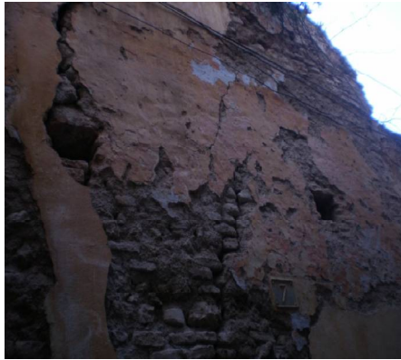
درب السلسلة، نلاحظ سقوط الملاط، وتشقق الجدران، مما سيؤدي حتما إلى
