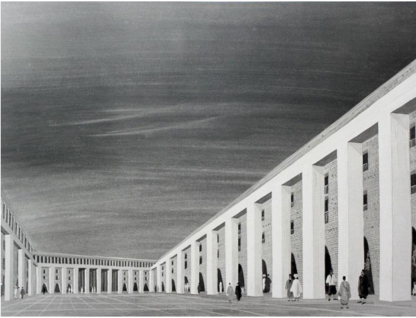
Fig. 4: Climat de France, le bâtiment des 200 colonnes à travers la grande place
