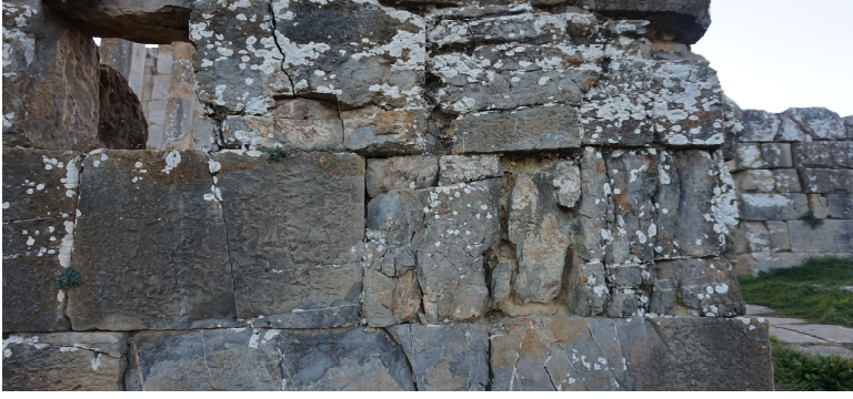
ملحق رقم (4): الصورة رقم 3: تشقق وتقشر الحجار على مستوى قاعدة قوس كركلا
