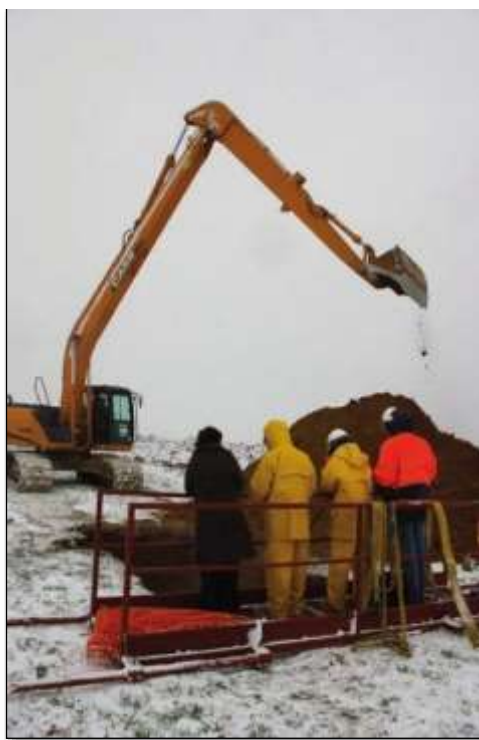
الشكل-5-: حفر سبر على شكل بئر بواسطة مجرفة ذات ذراع
