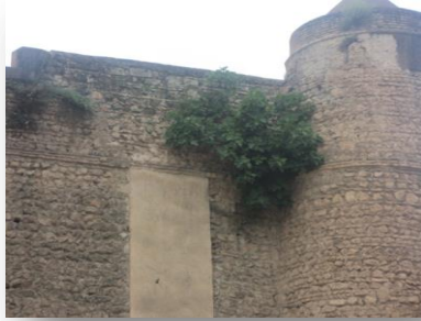
الصورة رقم: 5 ترسب الأملاح على الجدران. الصورة رقم: 6 ارتفاع نسبة الرطوبة في قواعد الأسوار
