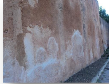
الصورة رقم: 5 ترسب الأملاح على الجدران. الصورة رقم: 6 ارتفاع نسبة الرطوبة في قواعد الأسوار
